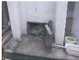
劣化（はく落した断熱材が点検口内に堆積）
