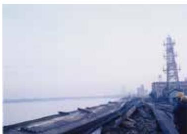
▲震災で沈下・崩壊した堤防（国土交通省近畿地方整備局淀川河川事務所提供）
